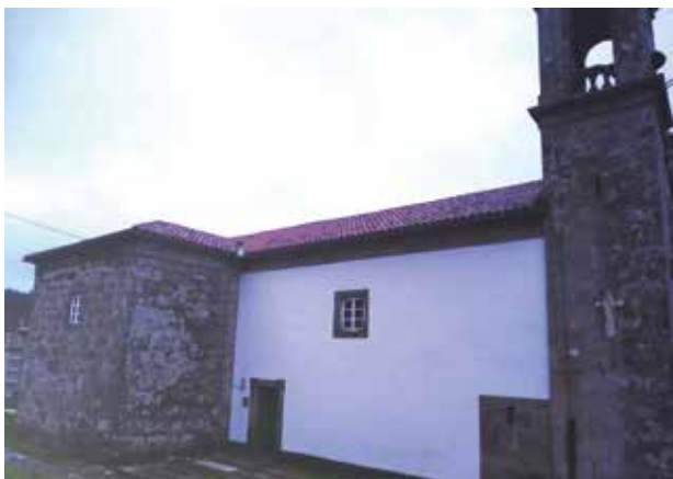
Los paramentos exteriores de la nave se limpiaron y se aplicó una pintura mineral
