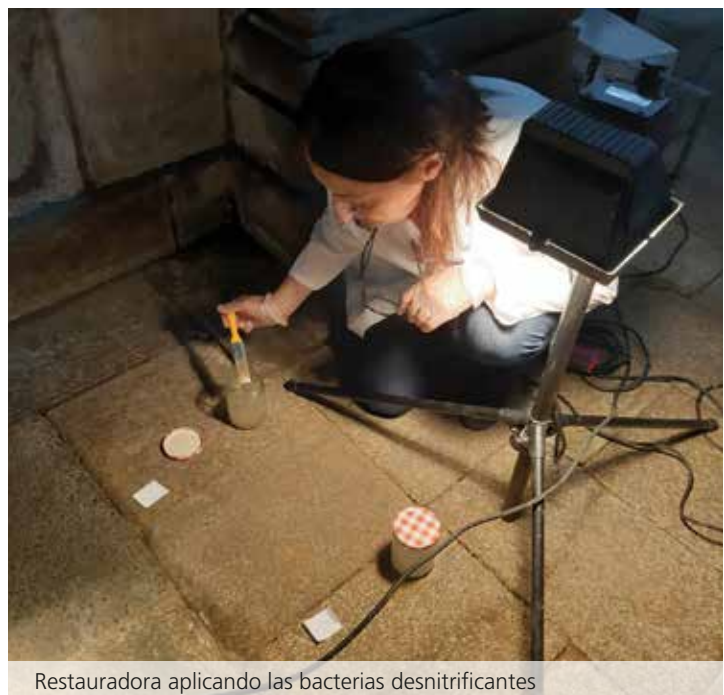
La desalación del suelo se realiza mediante un método basado en el empleo de bacterias
