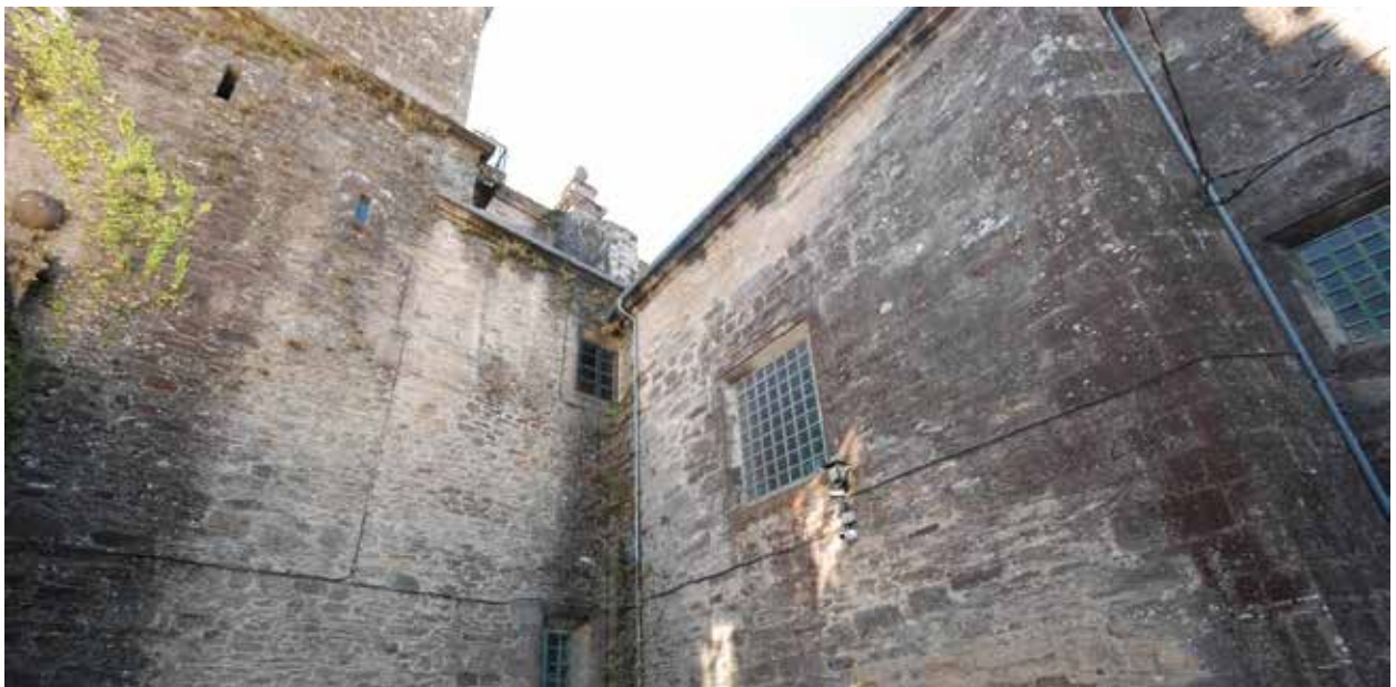
Se llevará a cabo la limpieza de las fachadas
